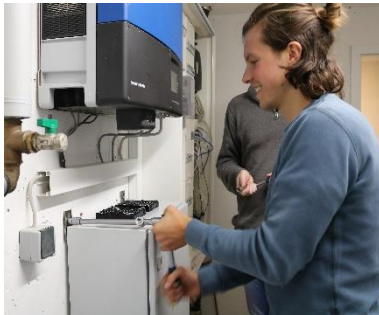
PIONIERKRAFT Geschäftsführer und Mitgründer Andreas Eberhardt bei der Installation der Pilotanlage
